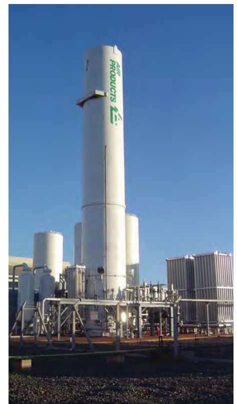
Air Products 為某巴西浮法玻璃客戶建造的現場制氮工廠
