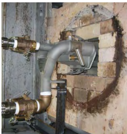
Cleanfire® HR/™ 扁平火焰燃燒器
